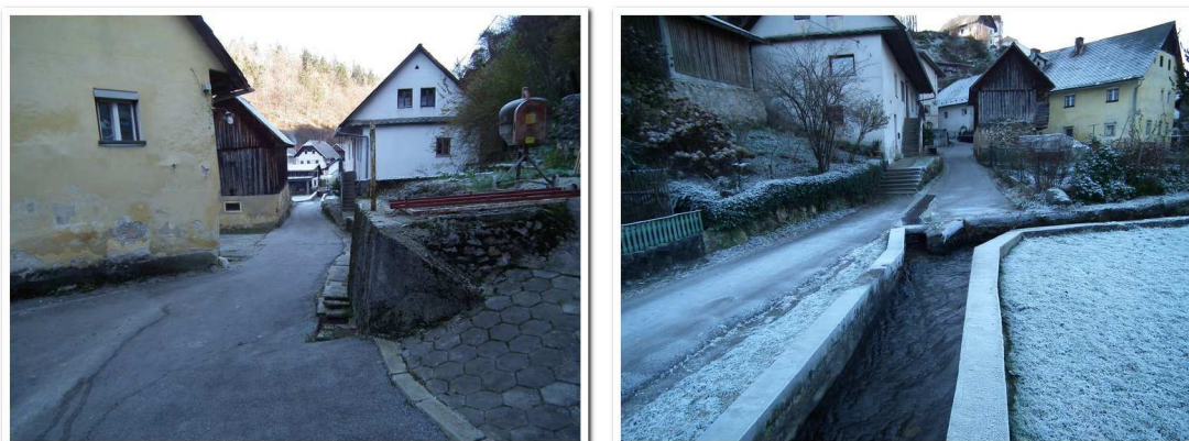
Slika 25: Potek prepusta med hišami in iztok prepusta \varnothing 40 cm v mlinščico: 3 in 4
