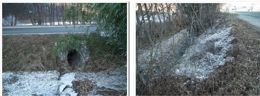
Slika 23: Fotografiji vtoka in iztoka drugega prepusta \varnothing 80 cm na HP17: 5 in 6
