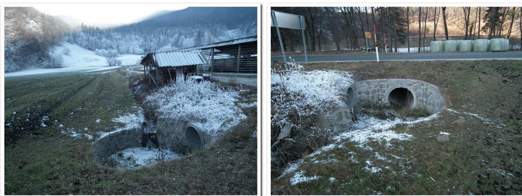
Slika 21: Fotografiji tretjega prepusta \varnothing 100 cm na HP17: 1 in 2
