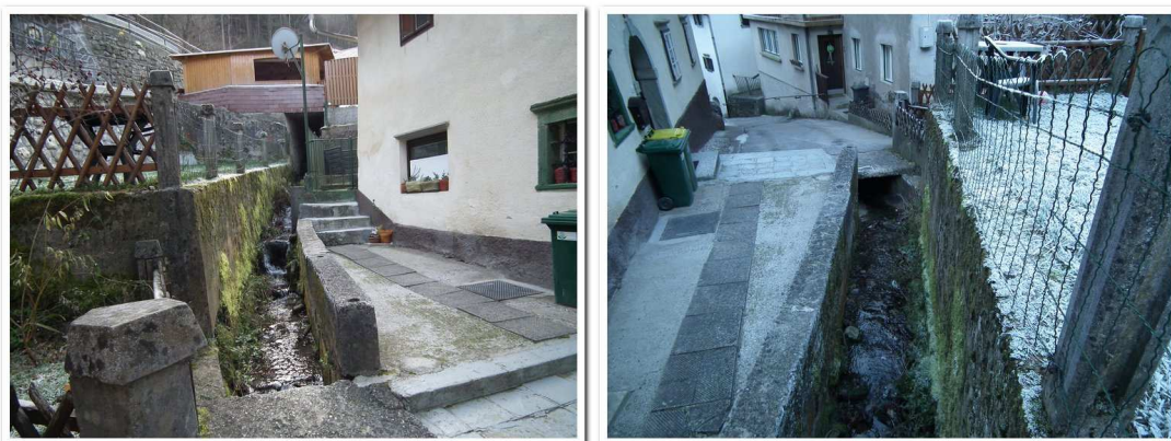
Slika 25: Fotografiji jarka in pokrite kanalete 70x70 cm na HP42: 1 in 2
