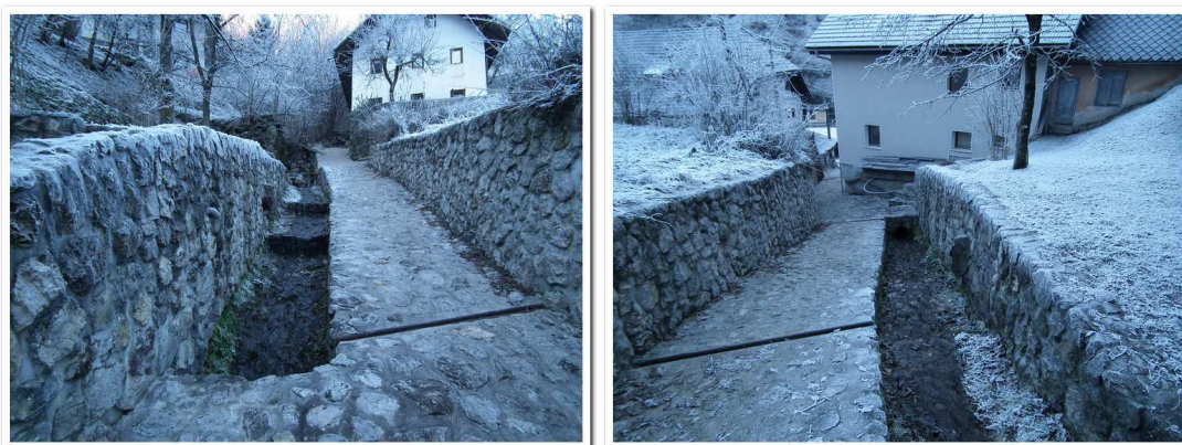
Slika 24: Fotografiji jarka in prepusta \varnothing 50 cm na HP41: 1 in 2
