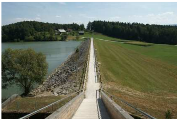
Pregrada na Šmartinskem jezeru. Kljub sumu, da pregrada pušča, so dokazali, da je pregrada varna.
