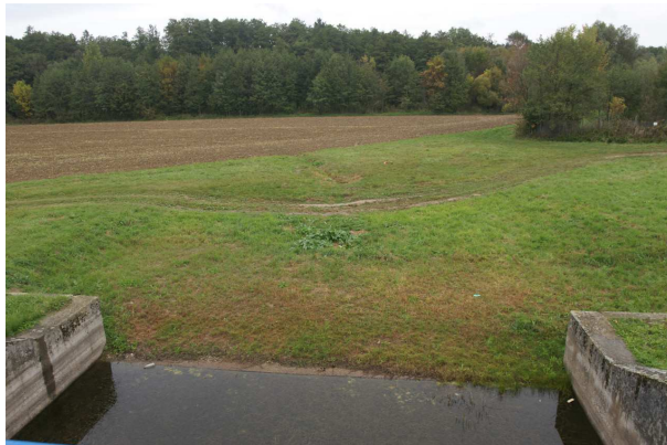
Vtok v suhi zadrževalnik Radmožanci (v času visokih voda je celotno območje vključno z gozdom poplavljeno).
