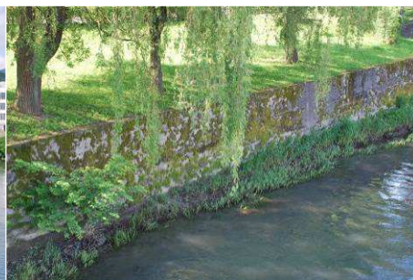
T129 G: Betonski obrežni zid na desnem bregu
