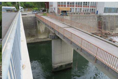
T135a D: Zaščita brežin na levem bregu v območju mostov
