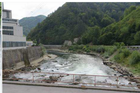
T135a D: Pogled dolvodno od mostu
