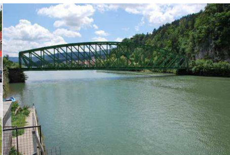
T143 D: Pogled dolvodno proti staremu železnemu mostu
