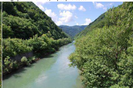
T135 G: Pogled s Trboveljskega mostu po Savi gorvodno
