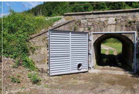
T131: Prehod pod nasipom z vrati, ki preprečujejo prelitje visokih voda skozi prehod v nasipu
