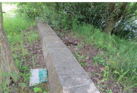
T145 D: Obrežni zid na levem bregu dolvodno od mostu v Radečah
