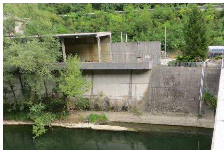
T135a G: Levi breg gorvodno od TET – obrežni zid nad mostom
