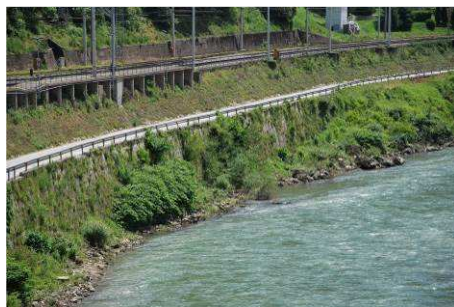
T137 D: Podporno-obrežni zid ceste v Hrastniku, levi breg
