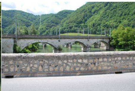
T142 D: Savinja v Zidanem Mostu, pogled dolvodno
