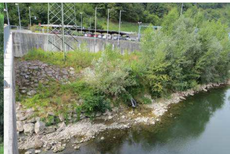
T135a G: Desni breg gorvodno od TET – zaščita brežin nad mostom
