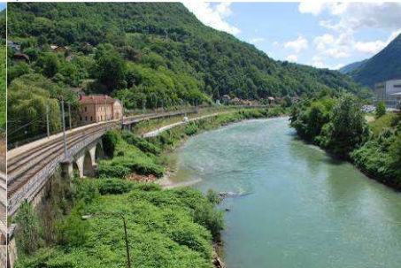
T137 D: Brežine v Hrastniku – pogled dolvodno z mostu
