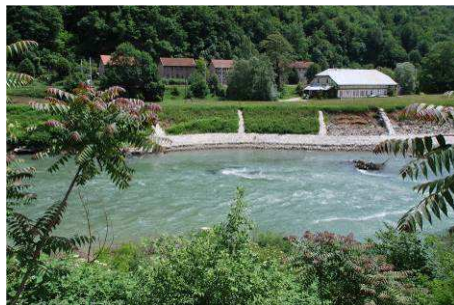
T139: Pogled na levoobrežno zavarovanje v Hrastniku
