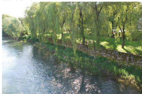
T129 D: Obrežni zid na desnem bregu, dolvodno od mostu
