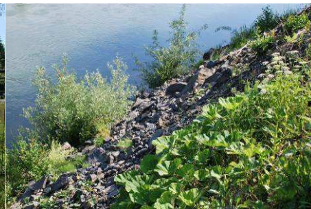
T126: Nasutje brežin z odpadnim gradbenim materialom na desnem bregu Save v Podkrajju
