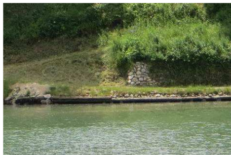
T145: Zavarovanje brežin na desnem bregu pod Novim Dvorom
