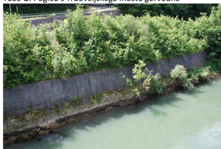
T135 G: Betonski zid na desnem bregu gorvodno od mostu
