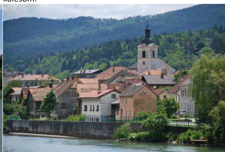
T143 D: Desnoobrežni betonski zid v Radečah
