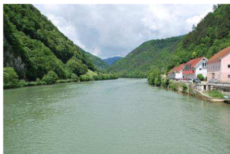
T143 G: Pogled s starega mostu gorvodno
