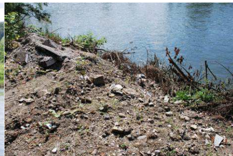
T130: Nasutje gradbenih odpadkov ob cesti do pretovorne postaje v Ponovičah
