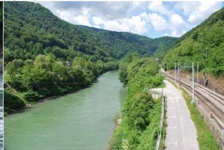
T137 G: Pogled s hrastniškega mostu gorvodno, žice preko struge so zaradi kajakaške steze
