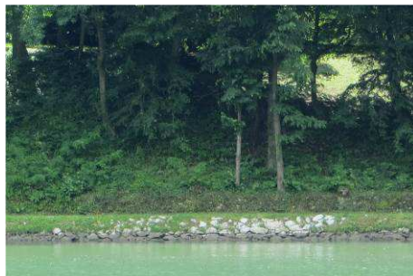
T145: Desni breg – obrežno zavarovanje iz lomljenca
