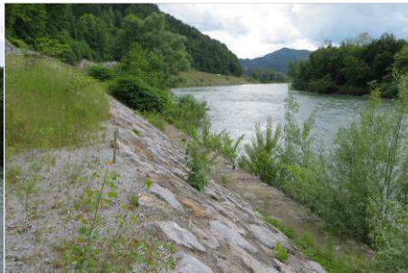
T124 D: Obrežno zavarovanje – zaščita ceste
