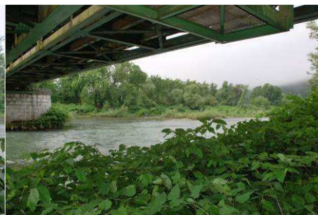
T125 D: Pogled dolvodno izpod železniškega mostu v Pogoniku.
