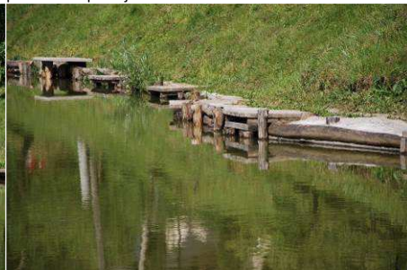
T131 G: »Pomoli« ob ribniku v Ponovičah, obrežno zavarovanje je izvedeno iz kombinacije lesa in betona
