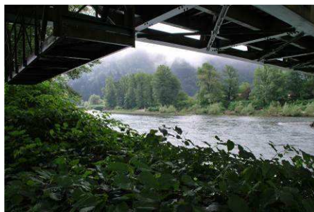
T125 G: Pogled gorvodno izpod železniškega mostu v Pogoniku
