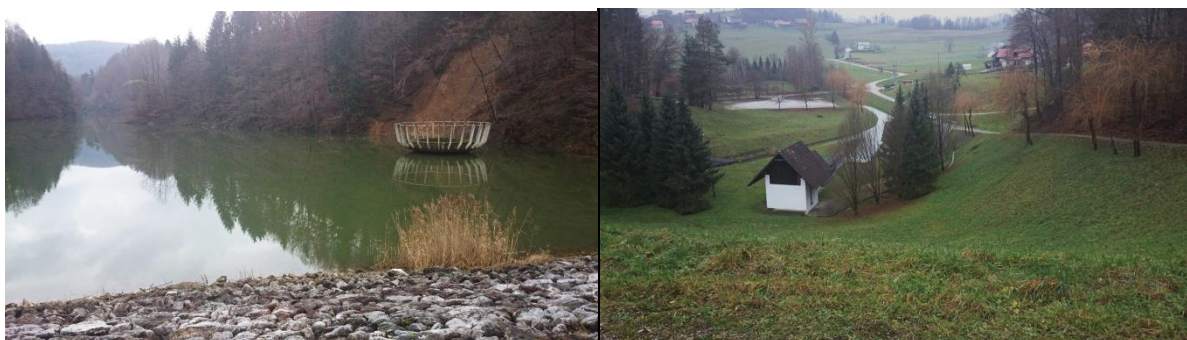
Slika 1: Pogled na Slivniško jezero z območja pregrade - levo in dolvodni pogled na čelni del pregrade (v ozadju MHE Tratna, talni izpust in izpust varnostnega preliva) – desno (foto: D. Lajevec, dec 2014)
