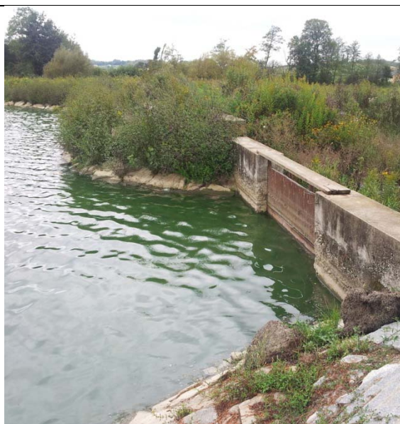
Slika 3: Pogled na akumulaciji Savci- Vir: IzVRS
