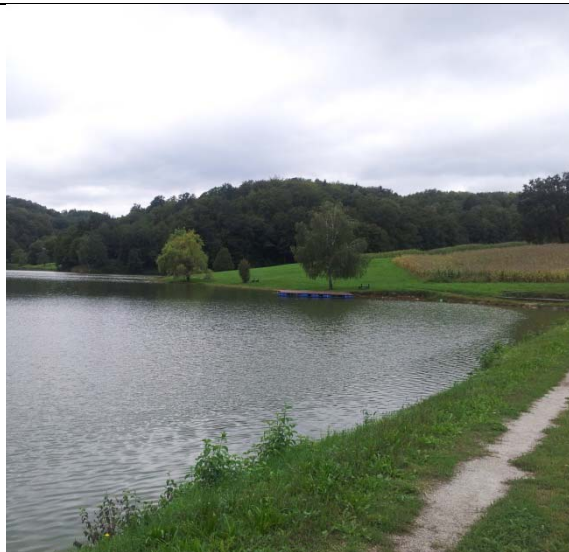
Slika 3: Pogled na akumulacijo Dežno 2 Vir: IzVRS
