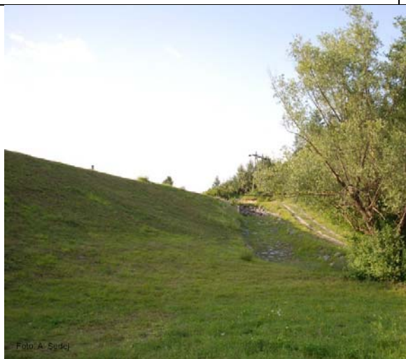
Slika 3: Pogled na suhi zadrževalnik Logatec
