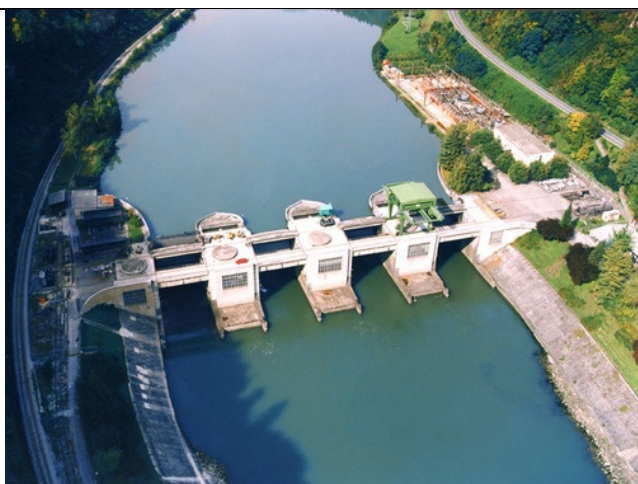
Slika3: He Ožbalt –pregrada akumulacije
