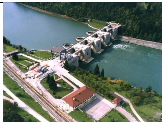
Slika 4: Pogled na pregrado He Vuzenica
