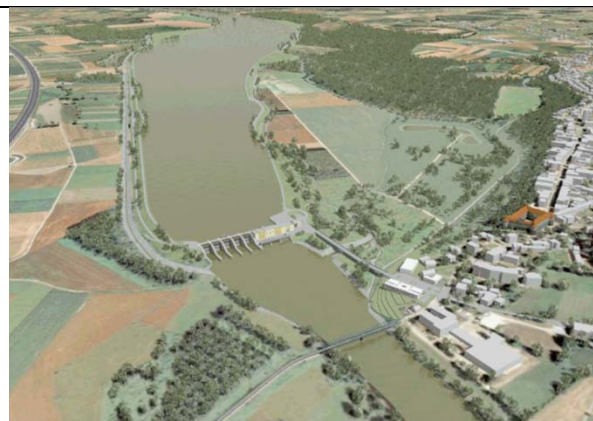
Slika 4: Lokacija He Brežice-po izgradnji
