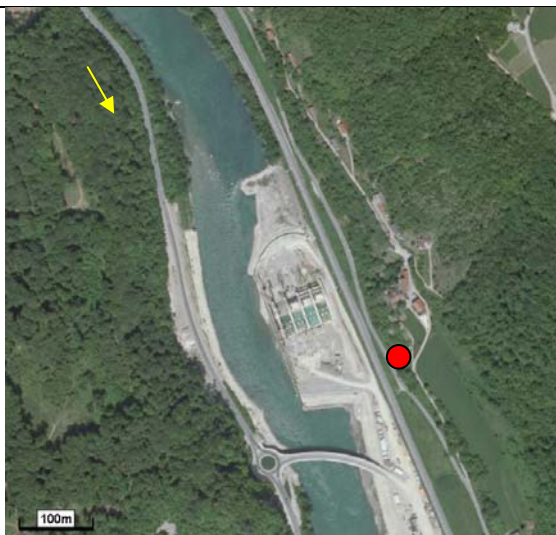
Slika2: Pregrada akumulacije He Krško med gradnjo hidroelektrarne-aereofotoposnetek
