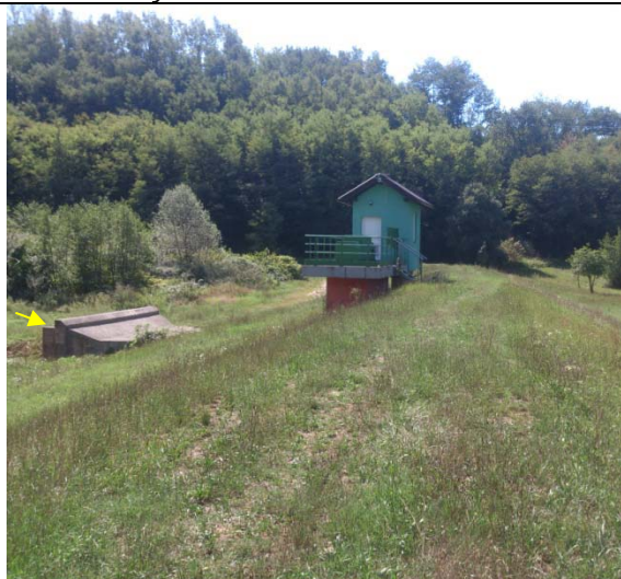
Slika 3: Pogled na pregrado suhega zadrževalnika Pikol
